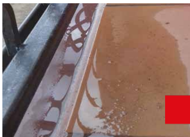
NIEWŁAŚCIWE ODPROWADZENIE WODY Z POSADZKI
